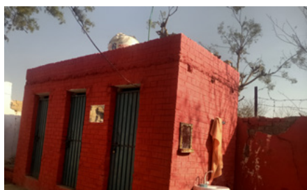
Die neu gebaute Toilettenanlage sorgt für hygienischere Zustände als vorher.
